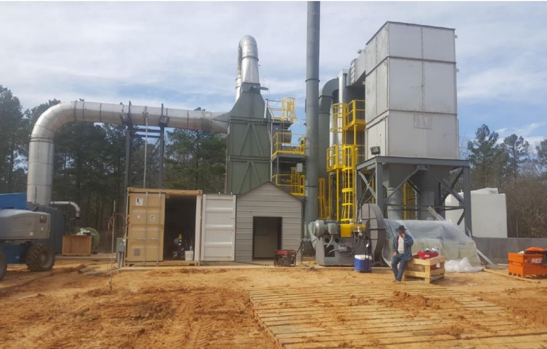
PAS System Construction
